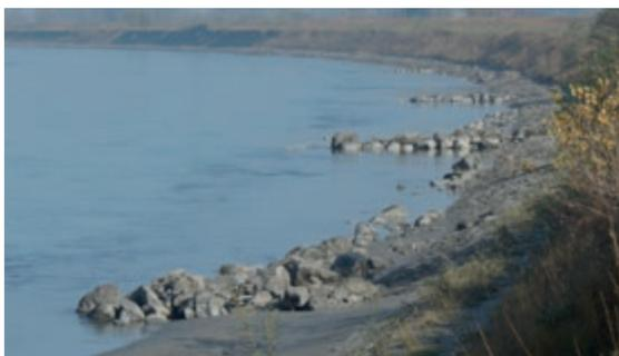
Aufgrund des hohen Abflusses und der Gewässerbreite können sich in diesem Abschnitt keine Kiesbänke mehr ausbilden, die Ufer sind mit Blockwurf fest verbaut. Die Buhnen am Prallhang stellen damit einzigen strukturbildenden Formationen dar.
